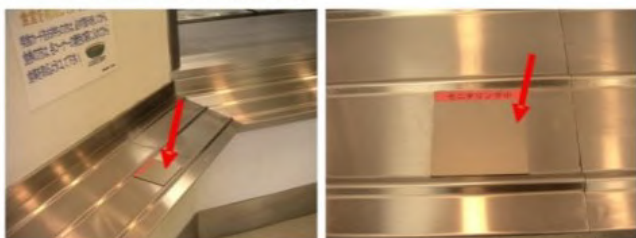
サンプルの設置状況(2009年1月、サンプル取り外し前)
